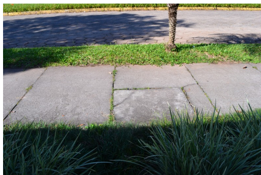
CALÇADA EXTERNA PRÉDIO ADMINISTRATIVO
